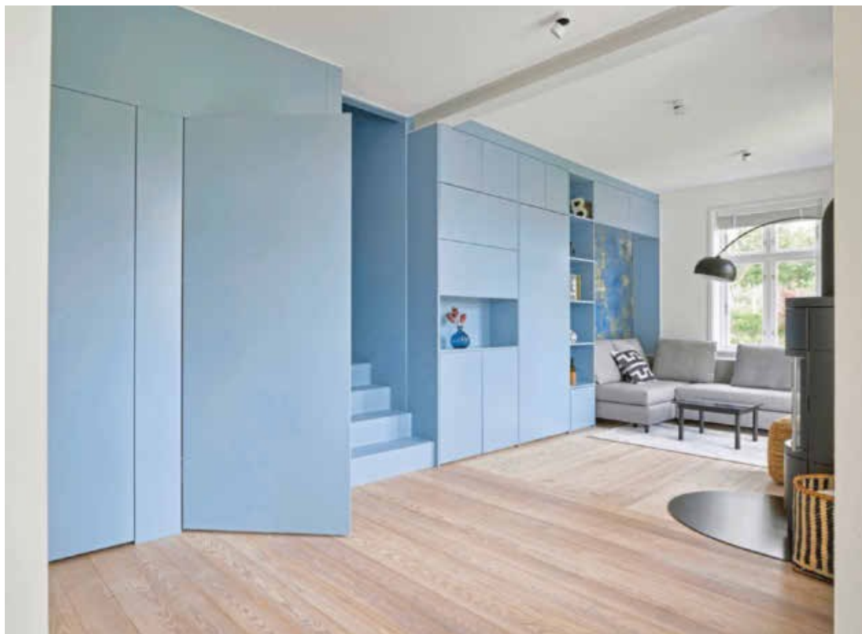
Lackierte MDF mit Grundierfolie für alle Fronten – die Tischlerei Eilun Werk auf Föhr setzt auf durchgängigen und sparsamen Materialeinsatz. Lackaufbau mit Produkten von Remmers
